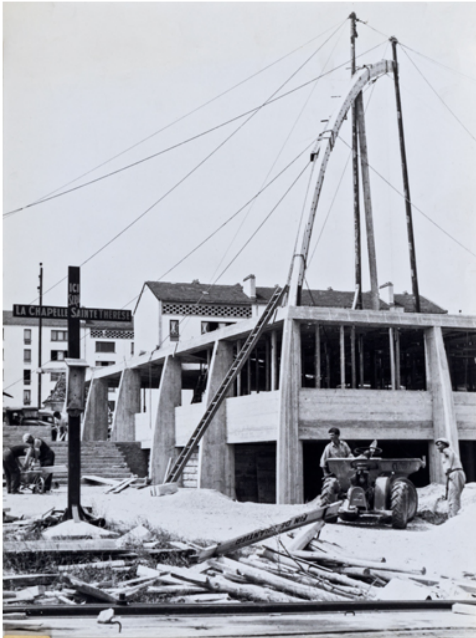
Église Sainte-Thérèse en construction, 1958.
