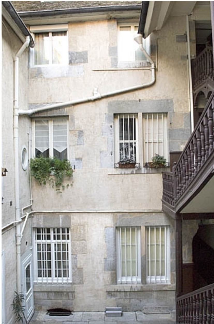
Vue d'ensemble de la façade sur cour du logis principal.
