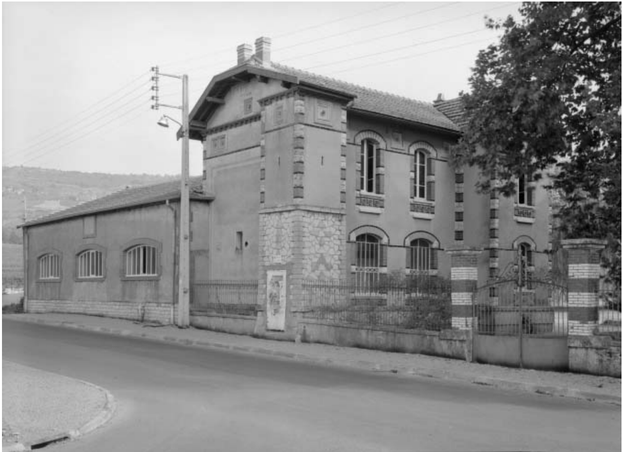
Bâtiment du forage et grille de clôture, vue depuis l'avenue des Sources, état en 1979.
