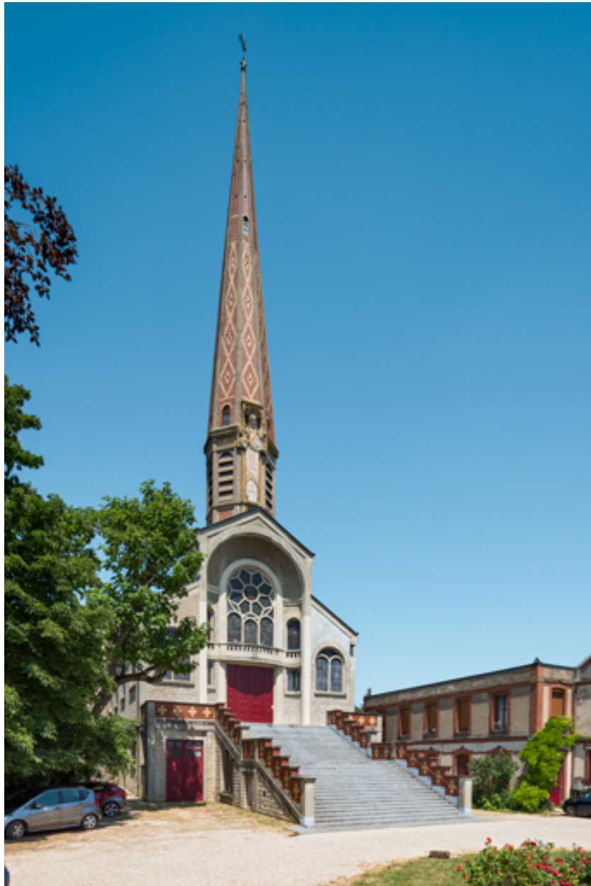
Eglise et chapelle. Vue de trois quarts.
