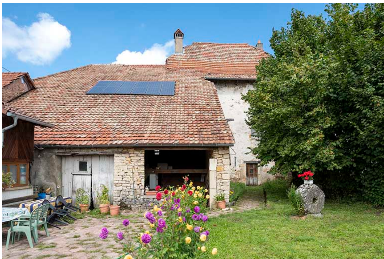
Maison et grange : façade postérieure.
