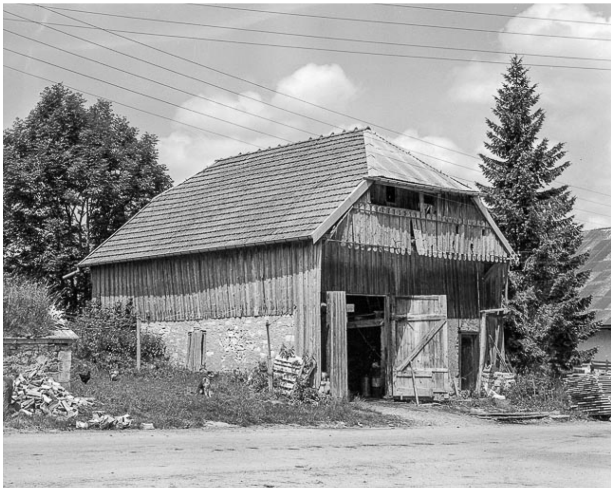
La remise, vue de trois quarts.
