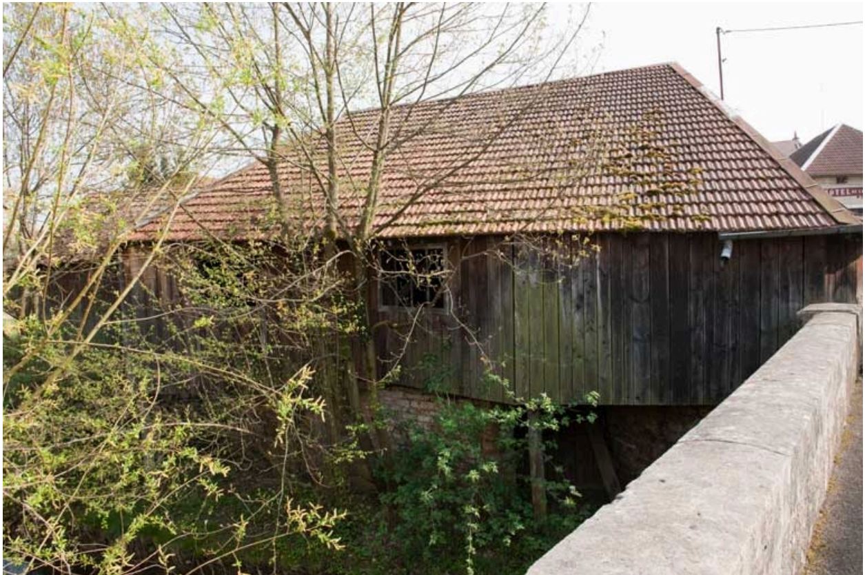
Scierie Courtot, rue du Pont : façade postérieure (côté Drigeon).
