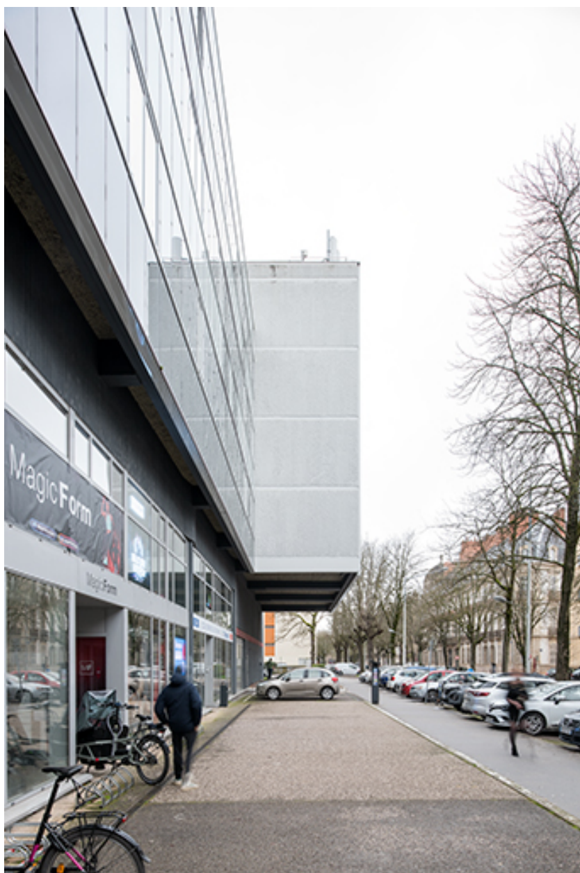
Façade nord-ouest, détail : avant-corps sud-ouest.
