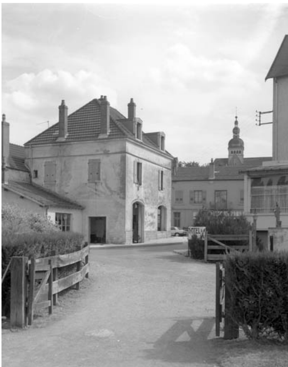
Façades postérieure et latérale gauche.
