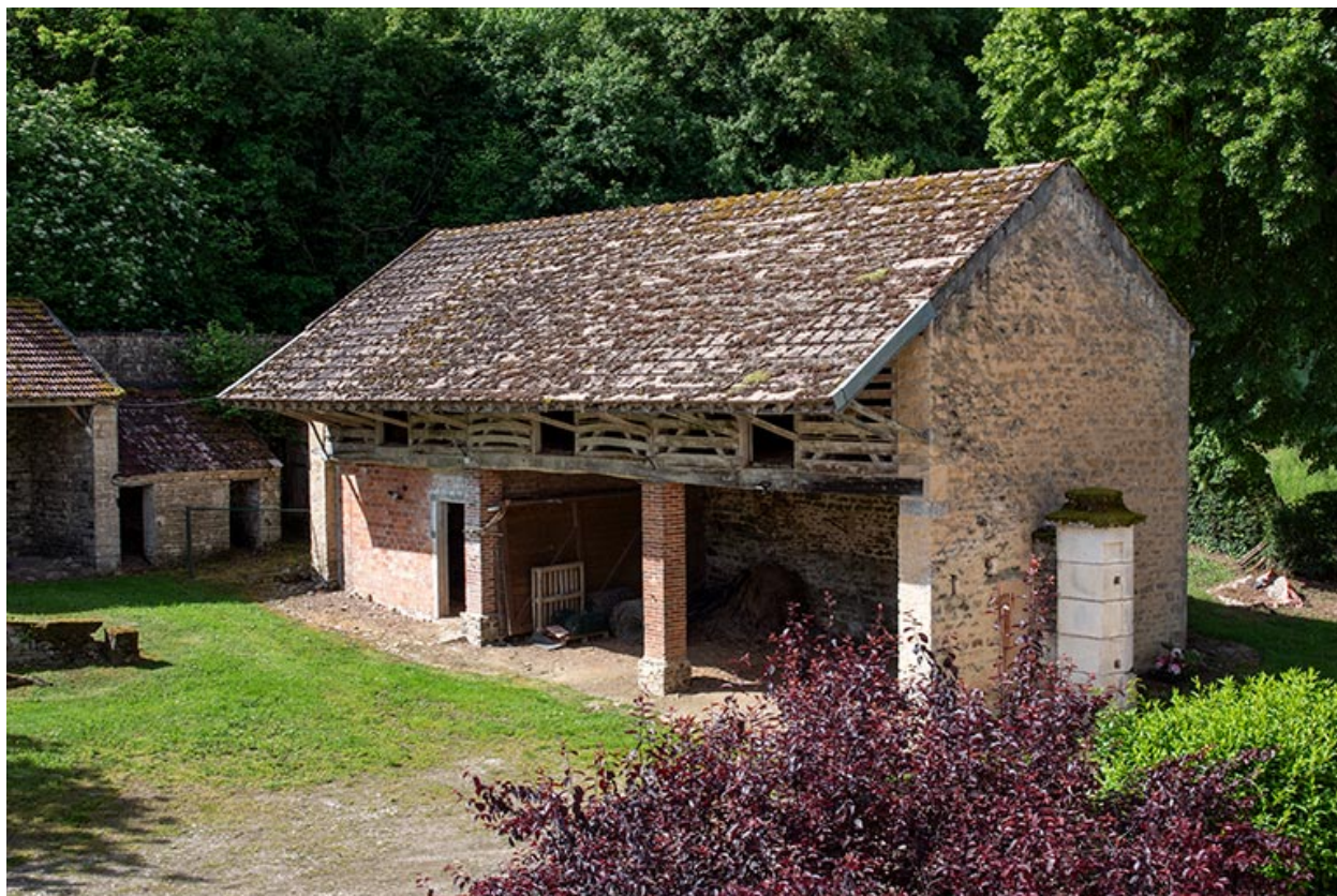
Le bâtiment du séchoir, de trois quarts.
