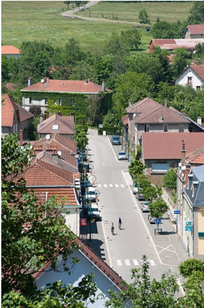
Vue plongeante sur l'avenue de la Gare et le bâtiment des voyageurs.
