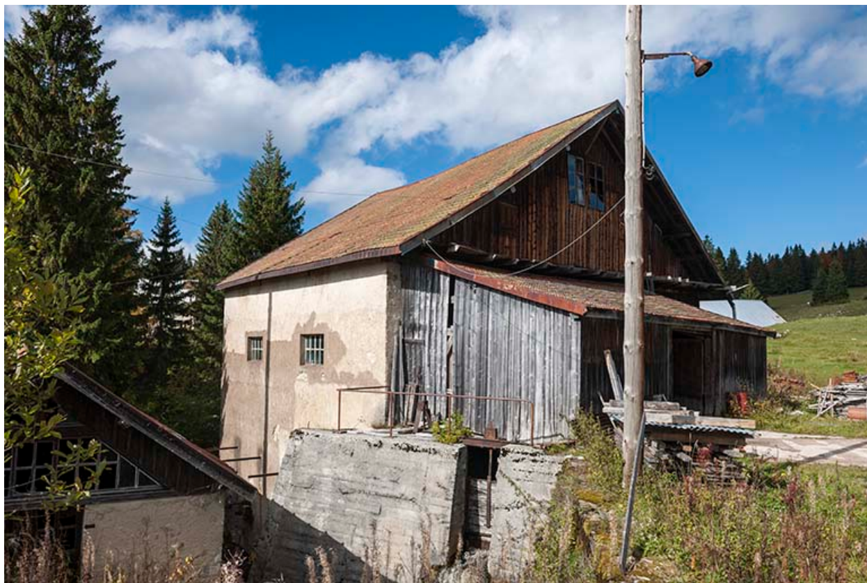
Atelier de scierie vu depuis le sud.
