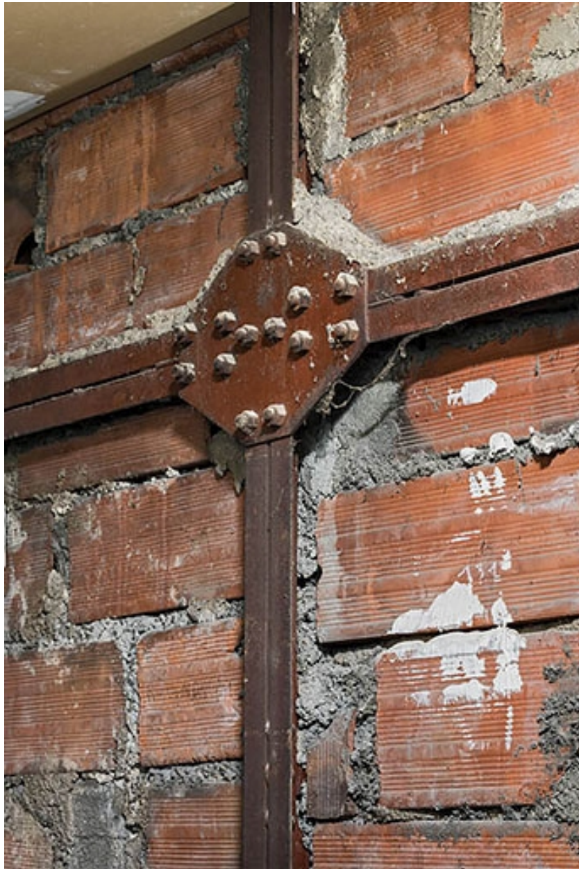
Détail du pan de fer d'un mur.
