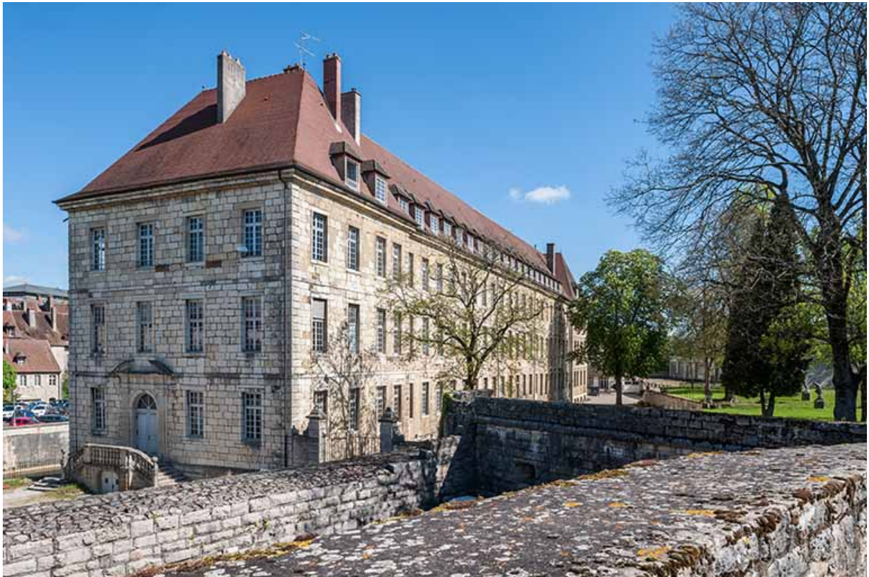
Ancien hôpital de la Charité, actuellement internat, vue façade postérieure et pignon ouest, remparts.
