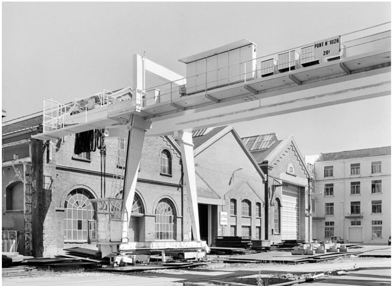
Rue 3 : pont roulant et ateliers de métallurgie.
