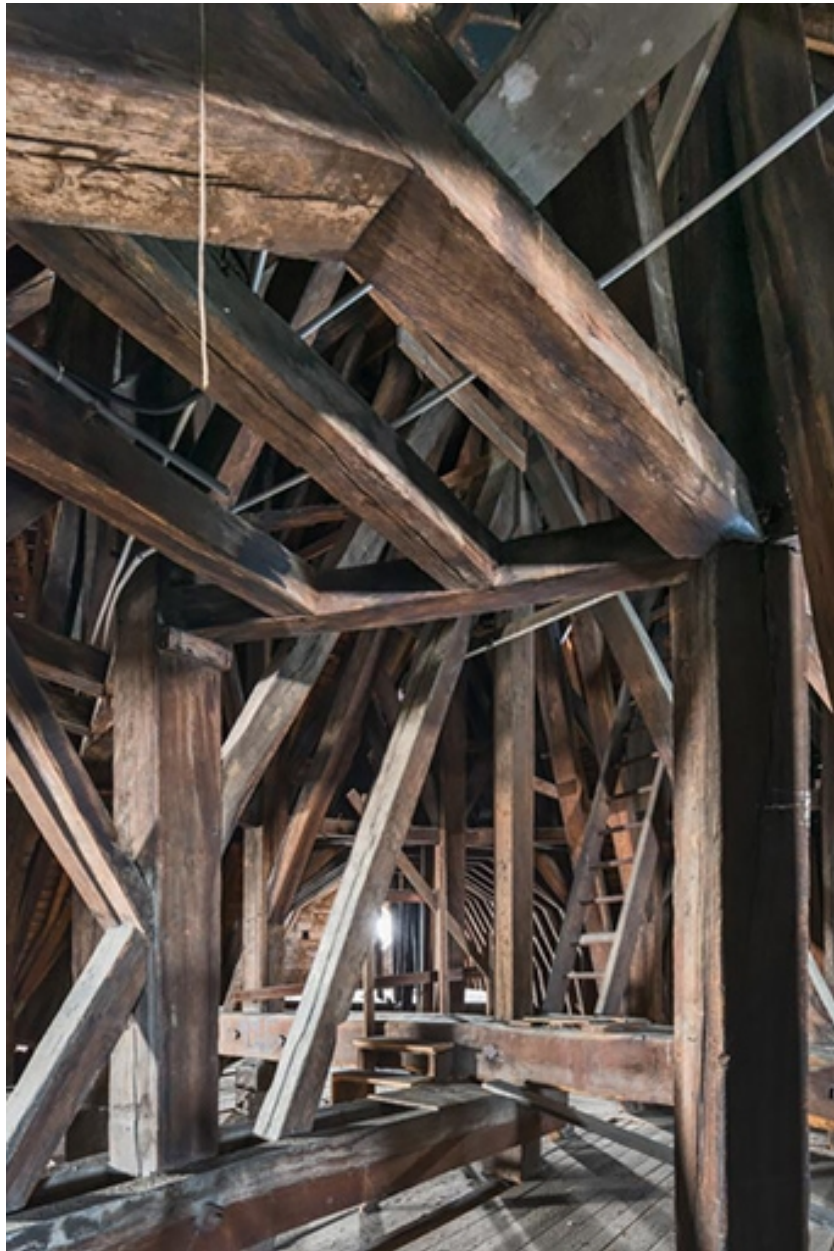
Comble : croisée du transept depuis le bras nord.
