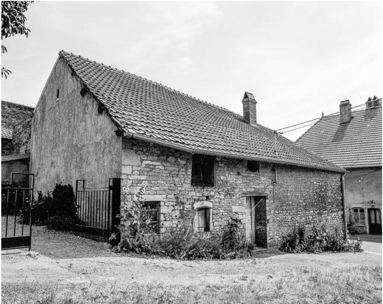
Maison située entre la rue d'Amont et la ruelle des Vignes : façade latérale gauche.
