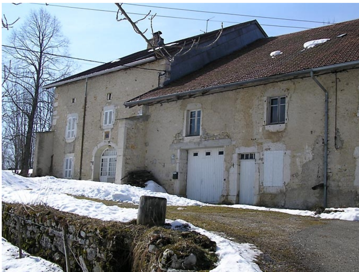
Vue de trois quarts sur l'édifice.
