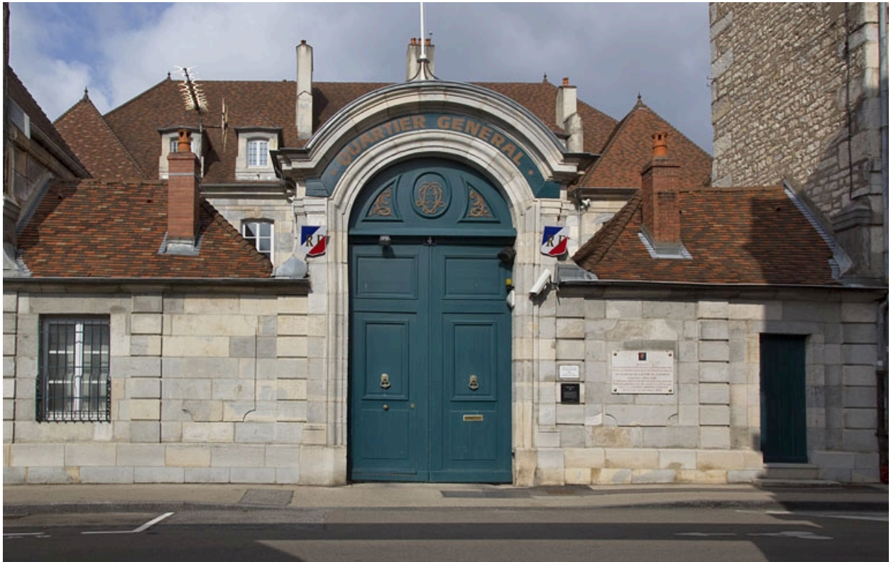
Vue du portail dans clôture : de face.
