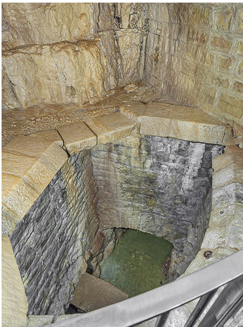
Intérieur de la place : puits au cavalier 12 (au nord du bâtiment).
