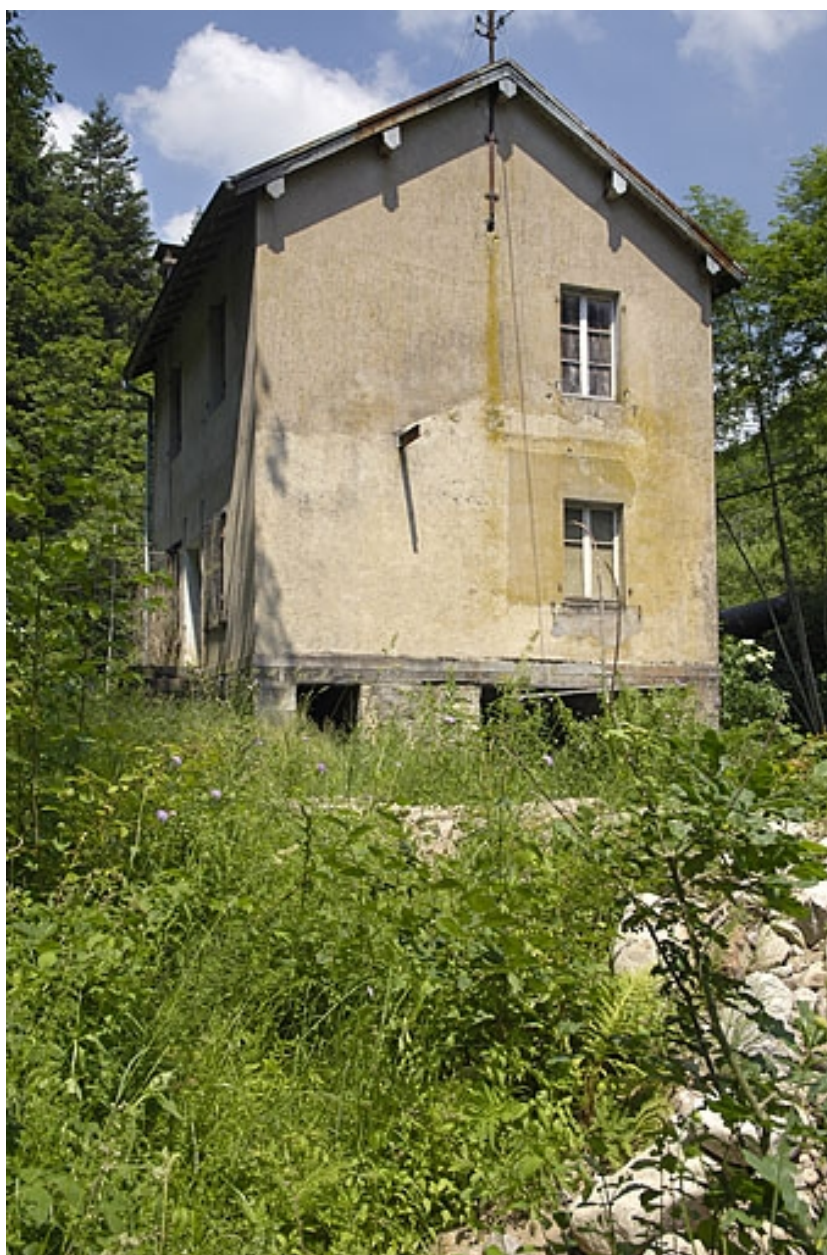
Elévation depuis le sud.
