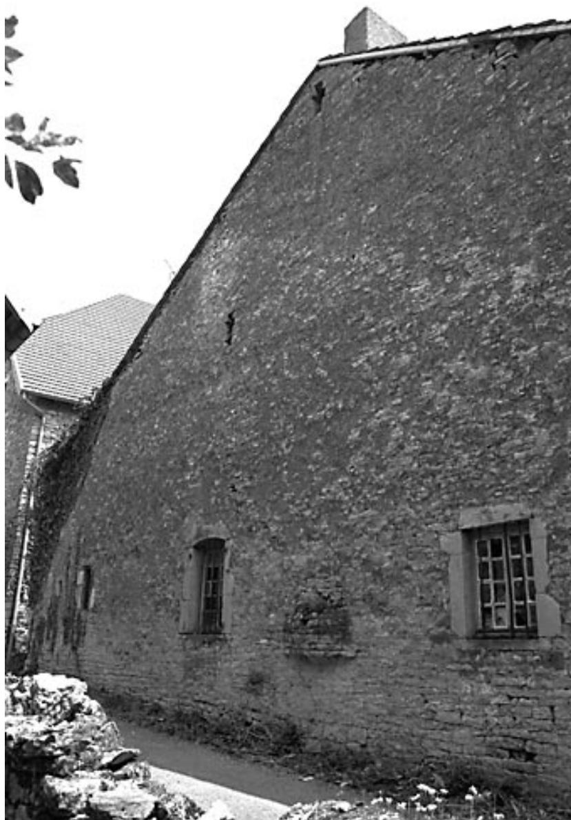
Façade latérale gauche.
