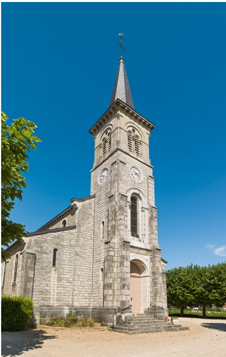
Façade et élévation ouest.
