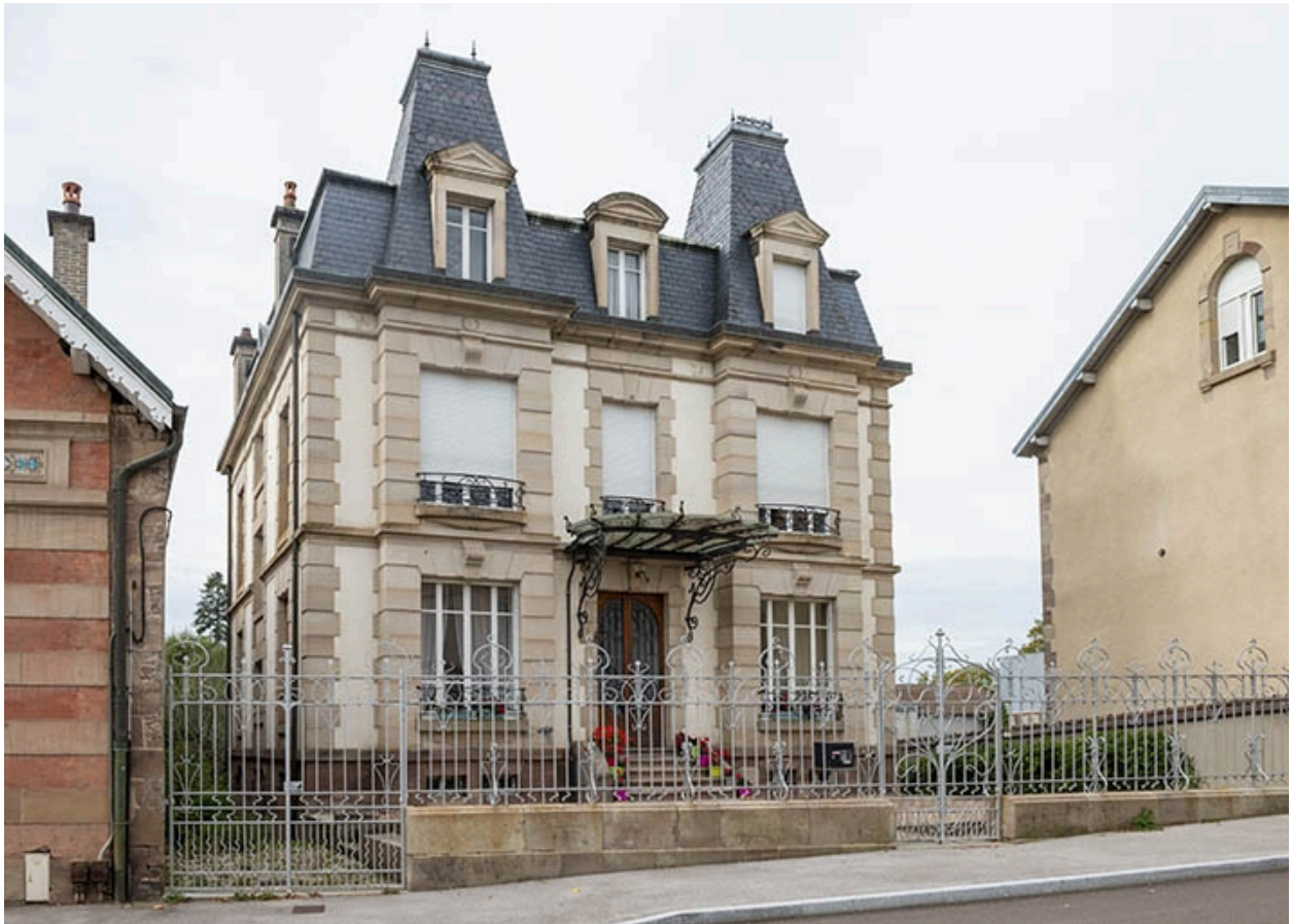
Façade principale, vue de trois quarts depuis le sud-est.
