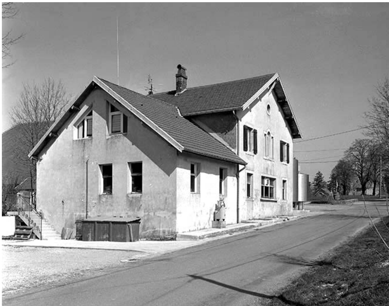
Façade sur rue de trois quarts gauche.
