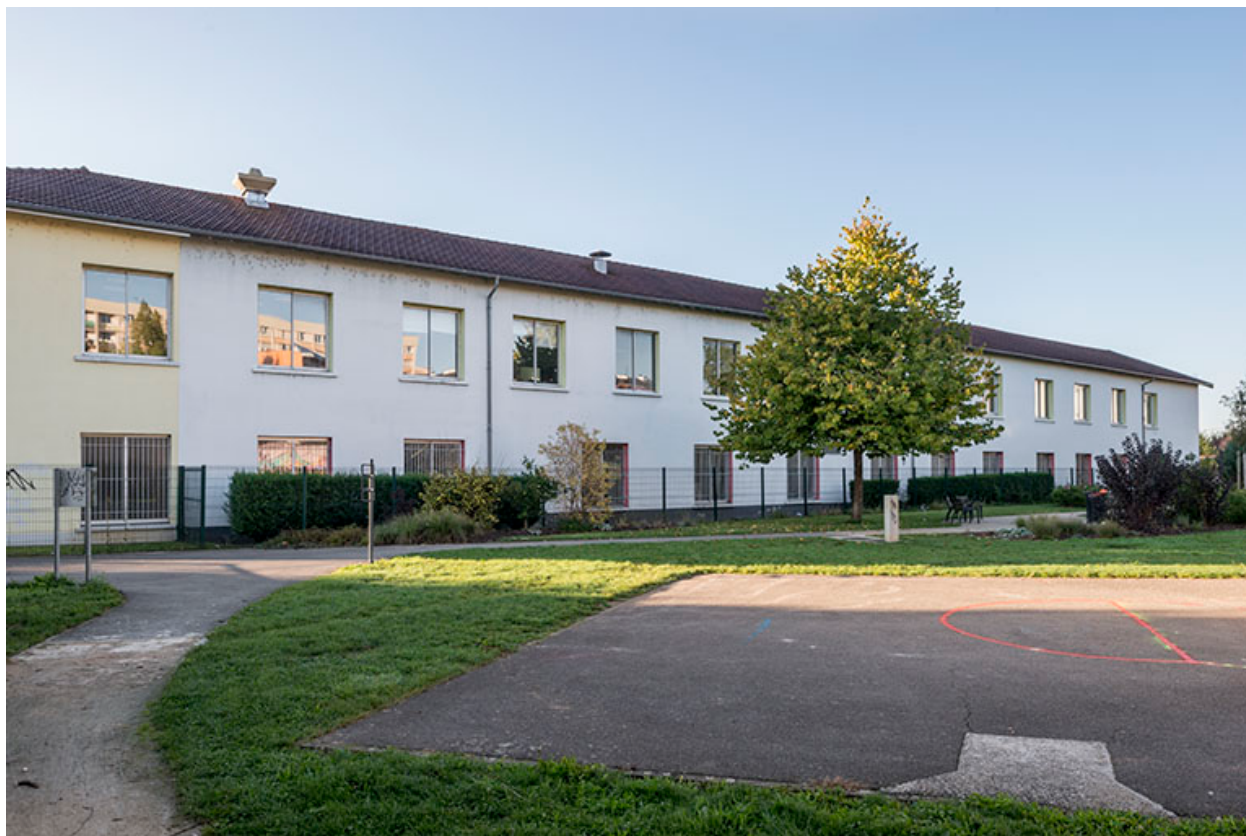
Façade nord de l'agrandissement (milieu 20e siècle).
