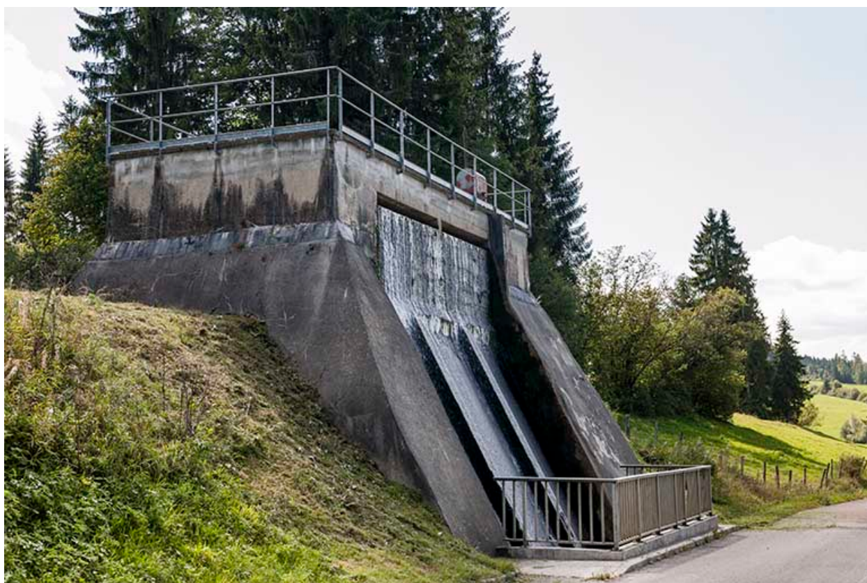
La chambre d'équilibre à l'aplomb de la centrale.
