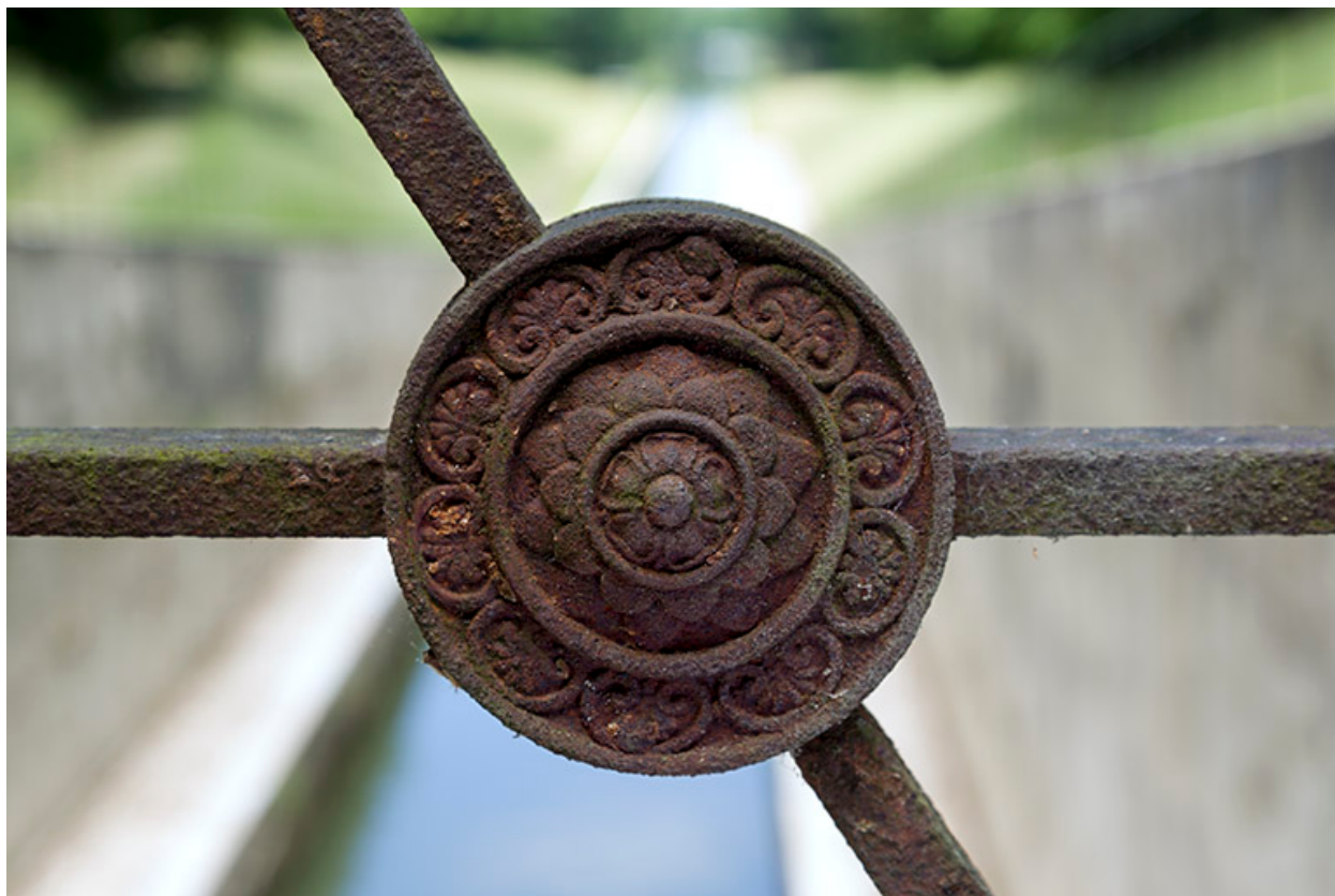
Détail, garde-corps de l'escalier.
