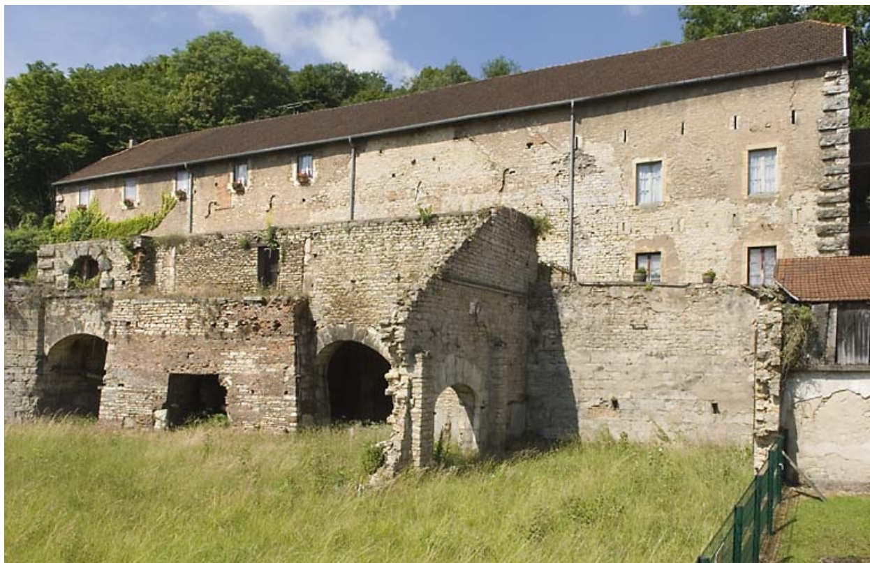
Halle à charbon et vestiges du haut fourneau. Vue de trois quarts.
