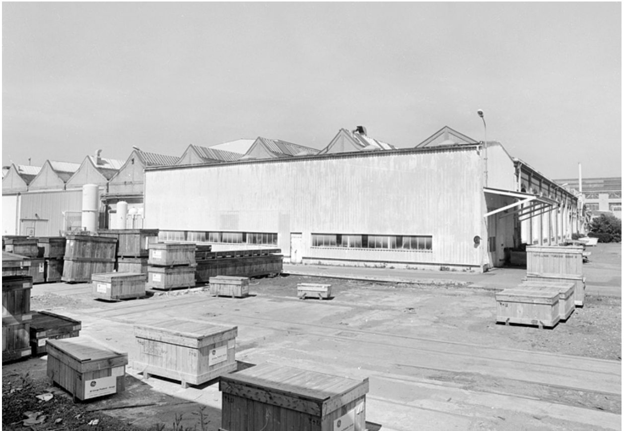
Aire de stockage et pignons de l'ancien atelier d'usinage des moyens moteurs.
