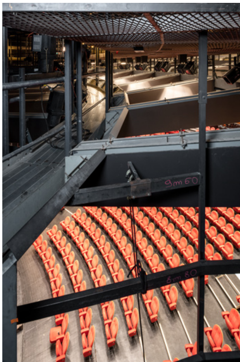
Maison de la culture, grande salle : charpente et passerelles techniques.
