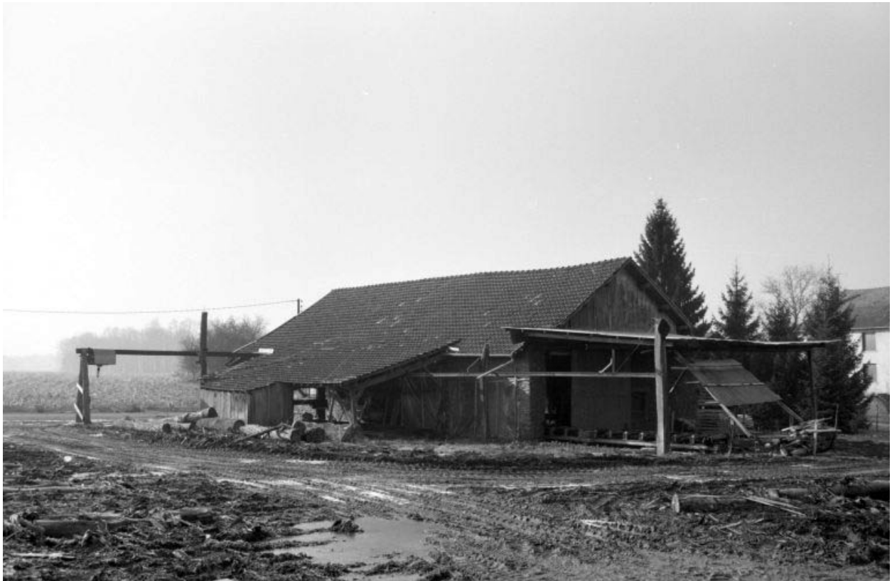
Atelier de fabrication, vu du nord-ouest.
