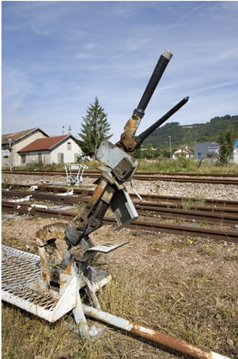
Levier de manoeuvre enclenché.
