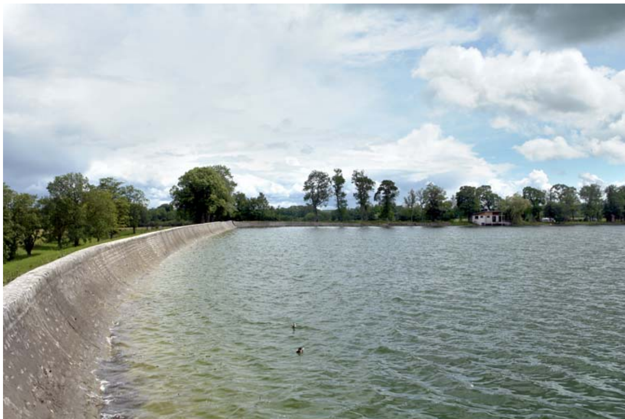
Vue de la digue principale.
