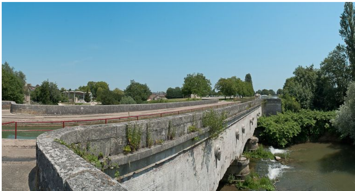
Vue du pont-canal.
