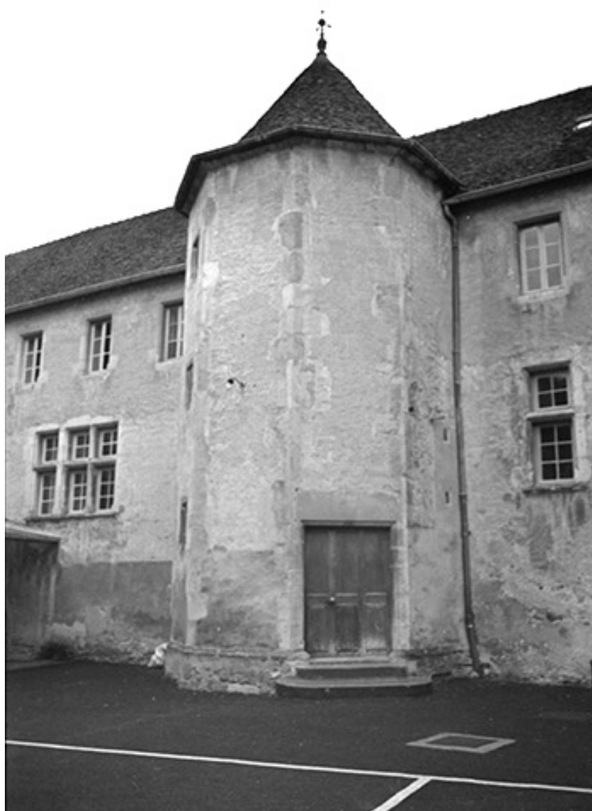
Tourelle d'escalier dans la cour.
