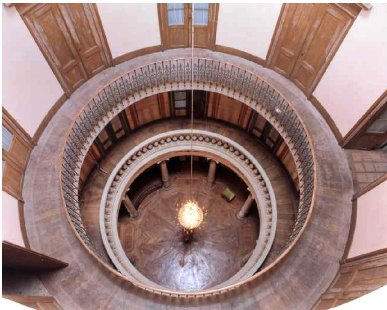
Intérieur : vue de la rotonde en plongée.
