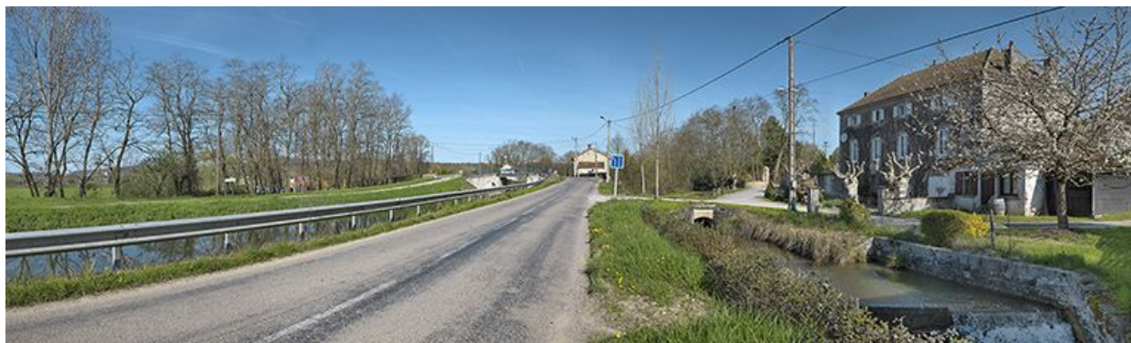
Rigole d'alimentation derrière la maison éclusière.
