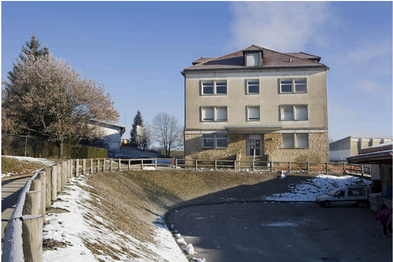
Site ancien, internat : mur pignon sud-ouest.
