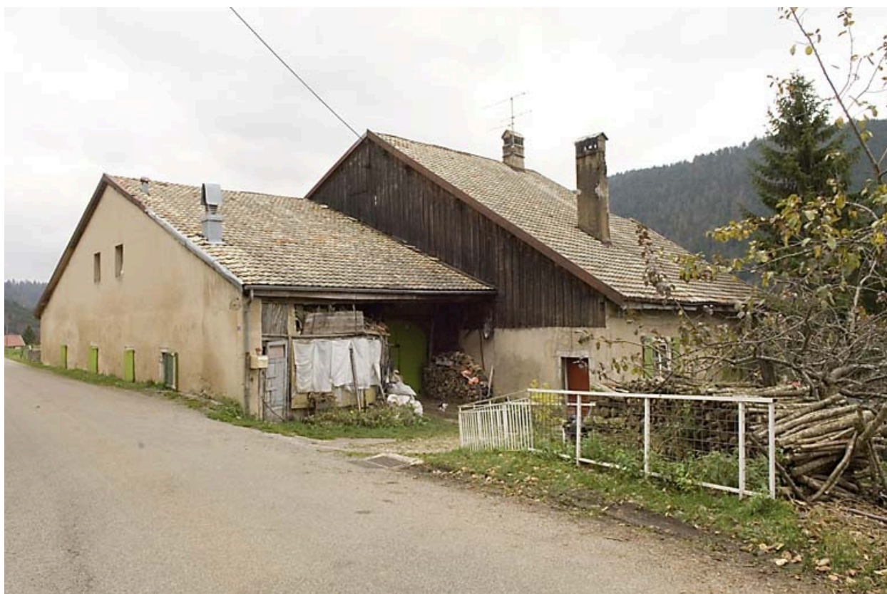
Façades sud et ouest.
