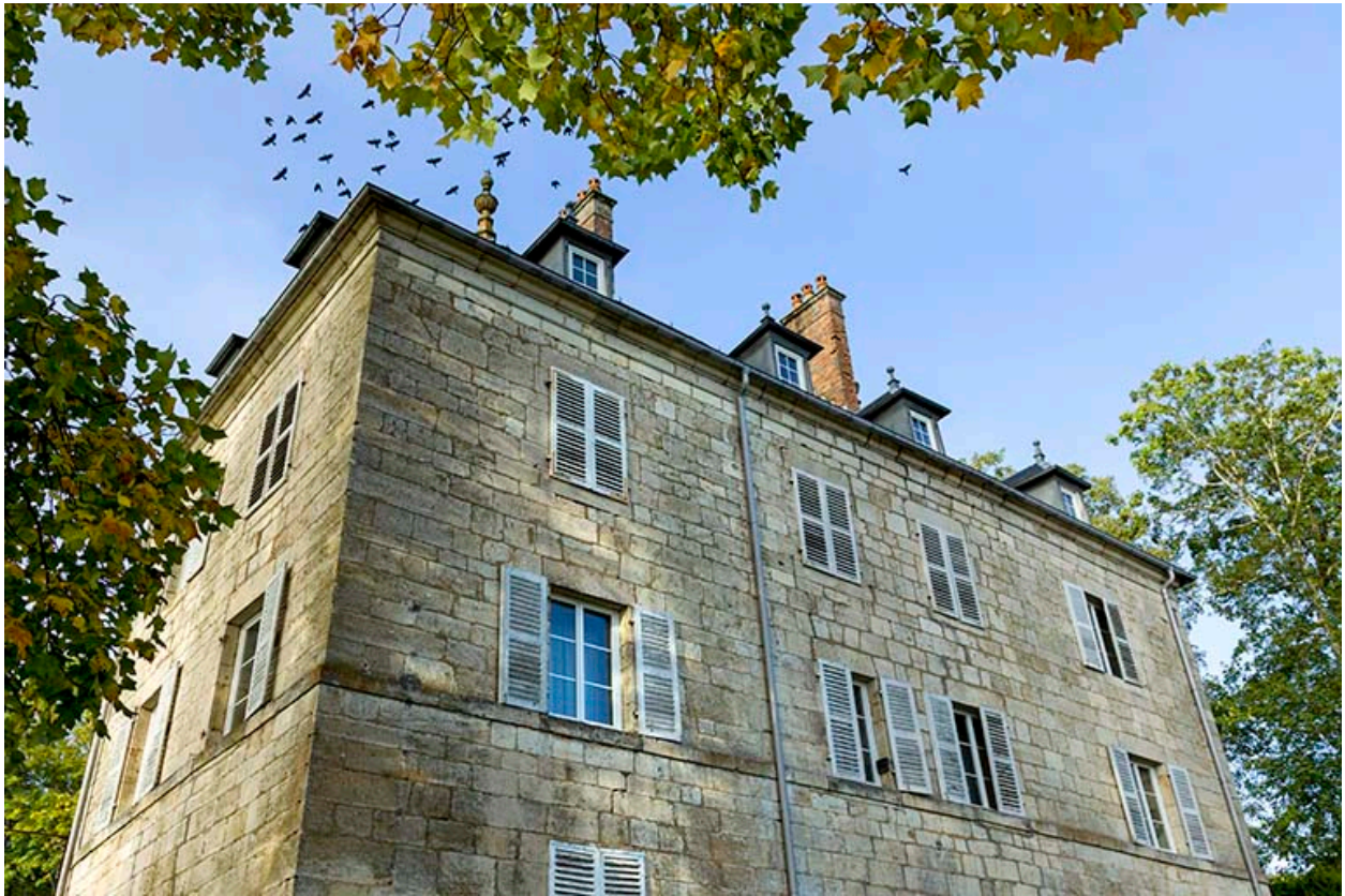
Façade postérieure et façade latérale droite.
