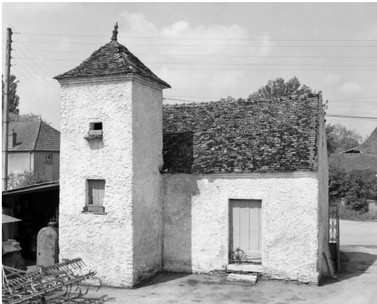
Colombier et remise d'une ferme (cad. 1981, sect. B2, parc. 345).
