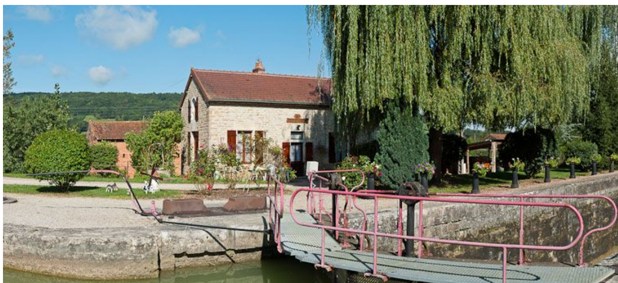
Vue du site d'écluse depuis l'amont.
