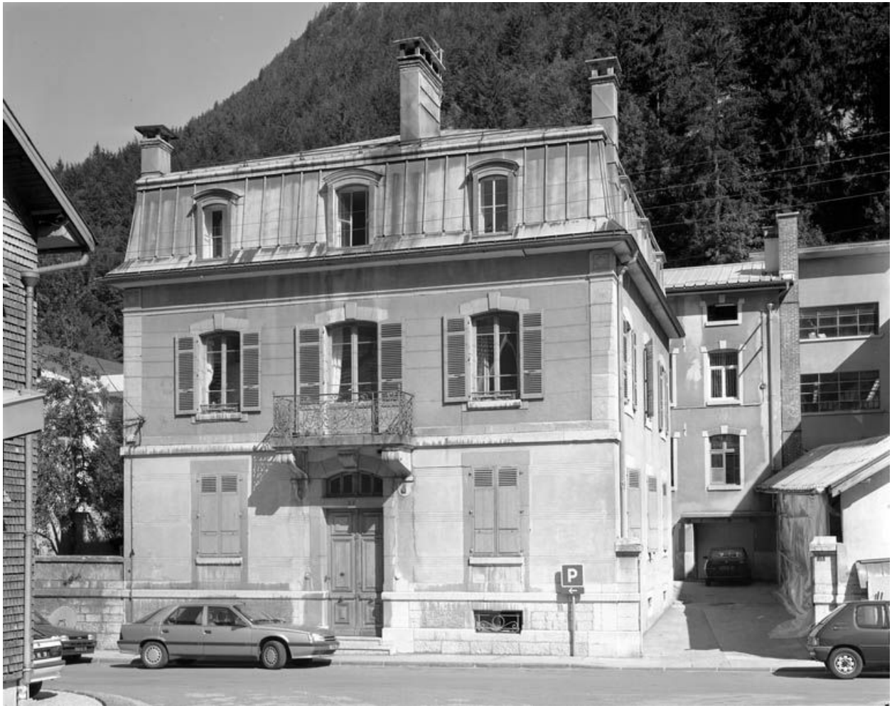
Site ancien : façade antérieure du logement.
