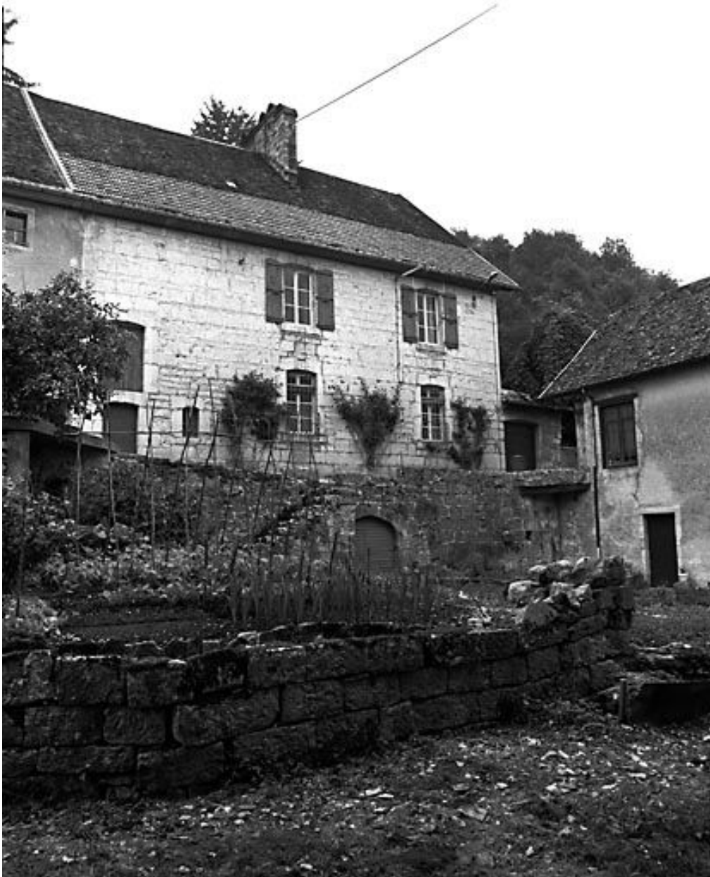
Relais de poste, actuellement maison, situé rue du Château.
