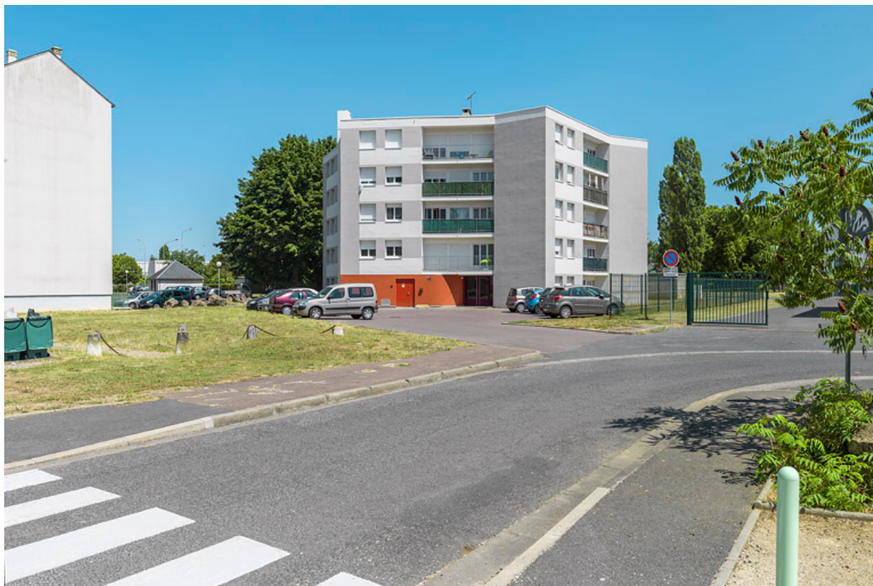
Bâtiment X, façades sud-ouest.
