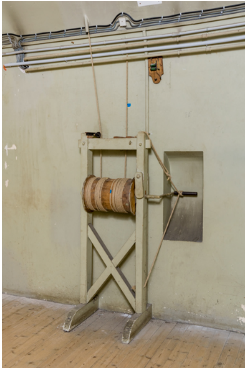
Sous-sol, salle du jeu d'orgue : treuil de commande du rideau de scène.
