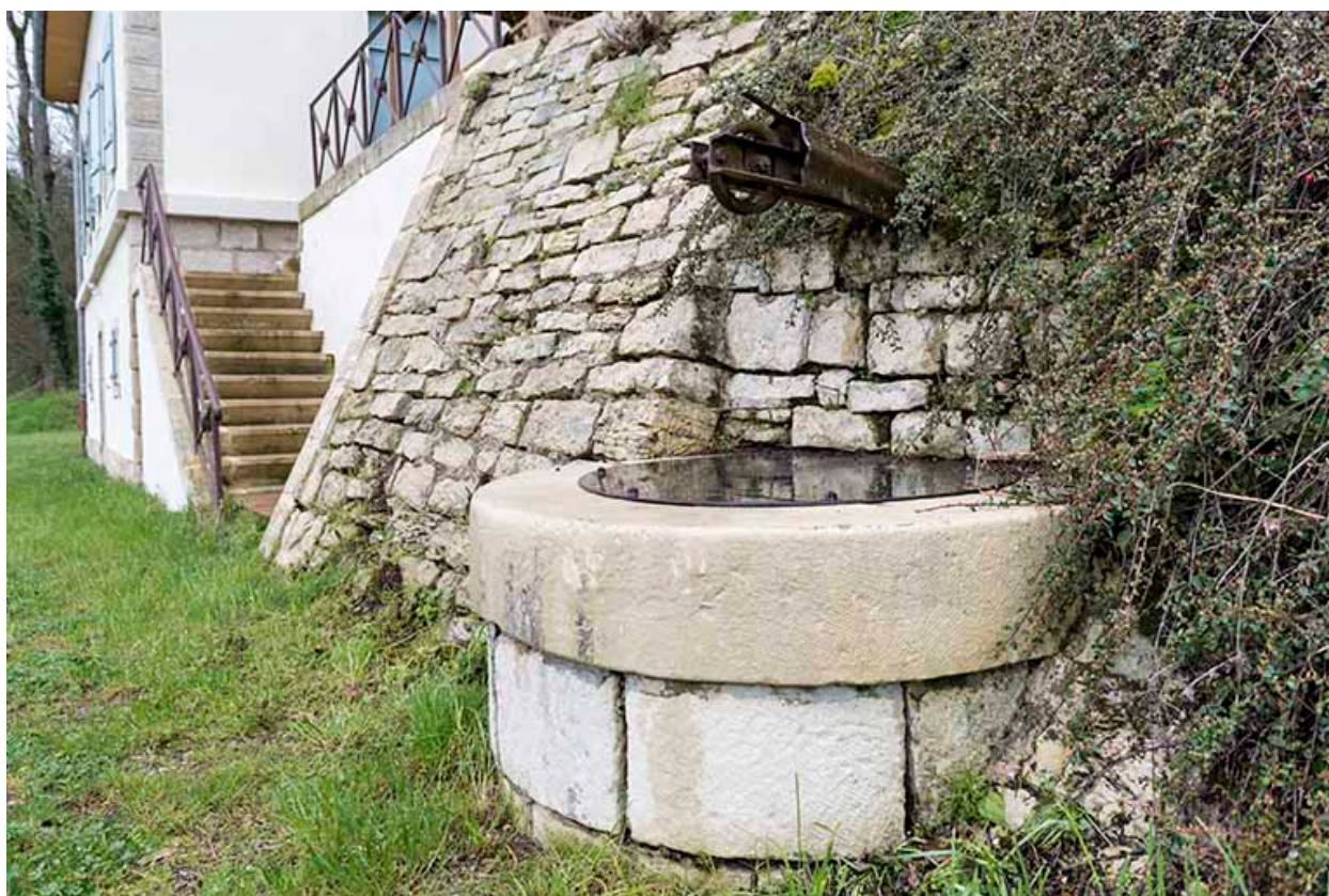
Puits de la maison.
