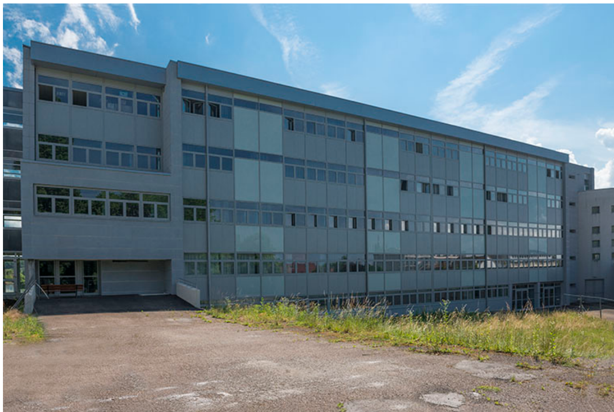
Façade ouest de l'externat.
