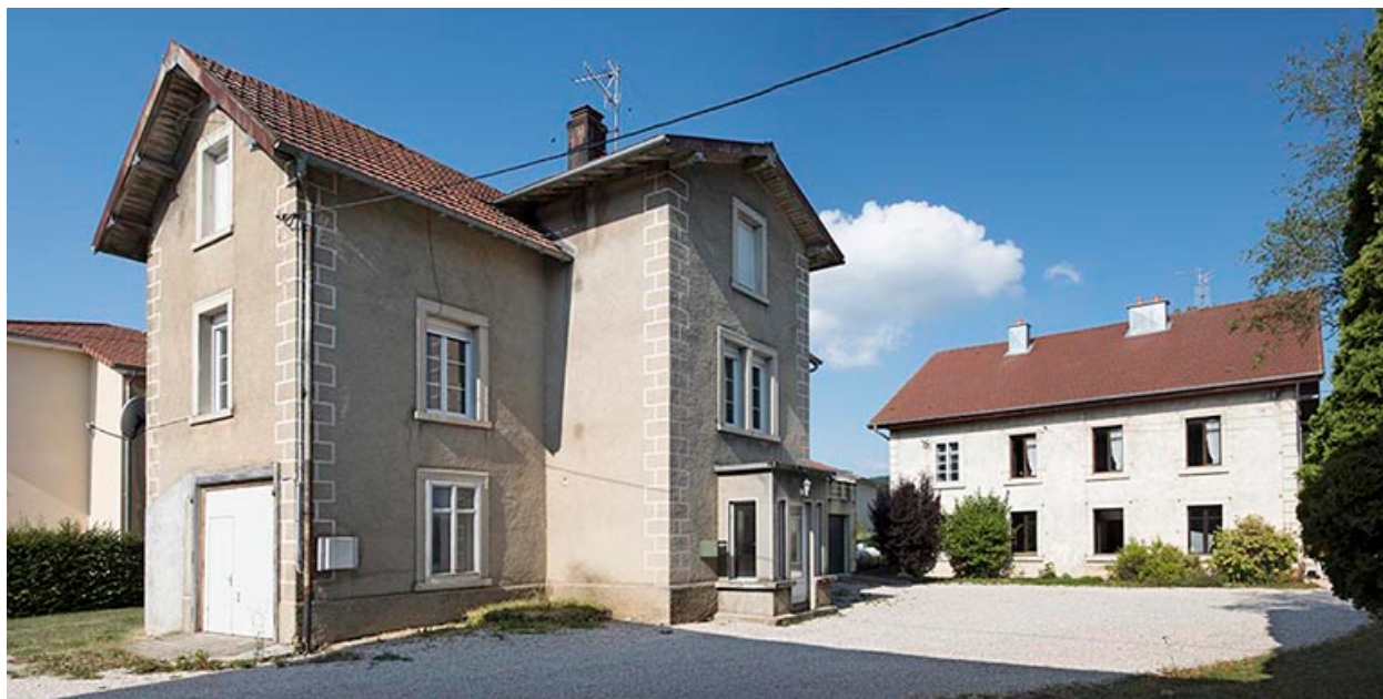
Logement de contremaître et maison, depuis l'est.
